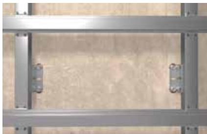
Kovová fasádna pod-konštrukcia
