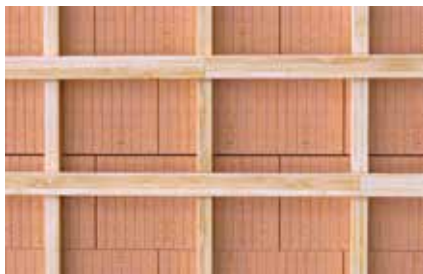
Nosné koňstrukcie z dreva
