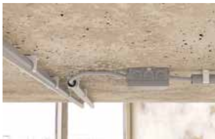
Upevnenie plastových izolačných trubiek
