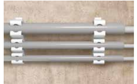
Upevnenie plastových izolačných trubiek
