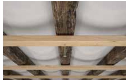
Stropné spodné konštrukcie
