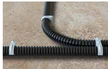
Upevnenie flexibilných trubíc
