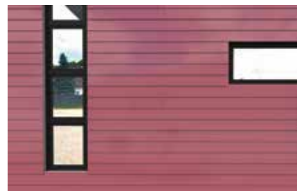
Nosné konštrukcie fasád
