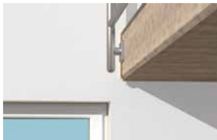
Styčné škáry v exteriéri
