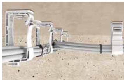
Zväzovanie elektrických káblov
