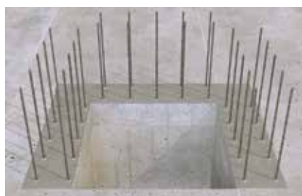
Dodatočne vlepené betonárske výstuže
