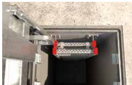
Vstup do prepadovej dažďovej nádrže
