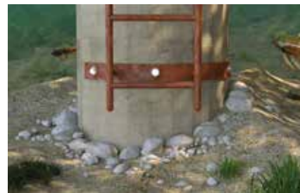
Aplikácie pod vodou
