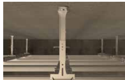
Podhľady upevnené na závesoch Nonius
