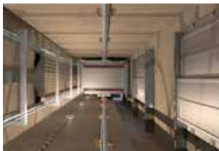
Výťahové vodiace koľajnice
