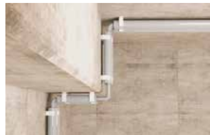
Upevnenie plastových izolačných trubiek
