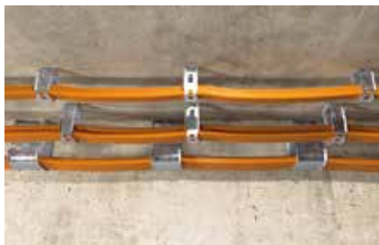
Upevnenie kábla na strop
