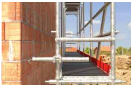
Kotvenie fasádneho lešenia
