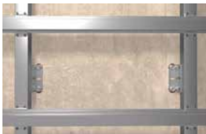
Nosné konštrukcie fasád
