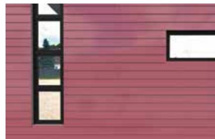
Nosné konštrukcie fasád
