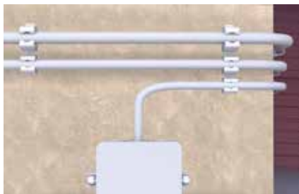
Upevnenie káblových trás
