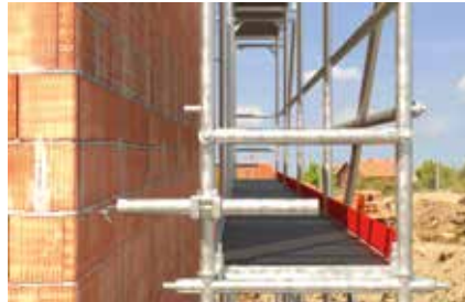
Kotvenie fasádneho lešenia
