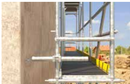
Kotvenie fasádneho lešenia
