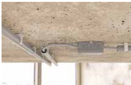
Upevnenie plastových izolačných trubiek
