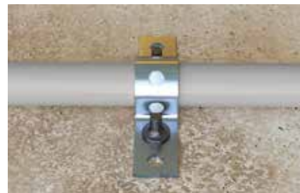
Ukotvenie dierovaných pásov
