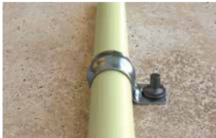
Upevňovanie oplástených trubiek
