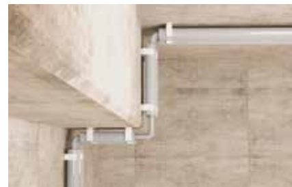
Upevnenie plastových izolačných trubiek
