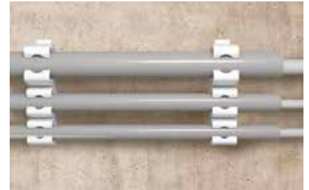
Upevnenie plastových izolačných trubiek
