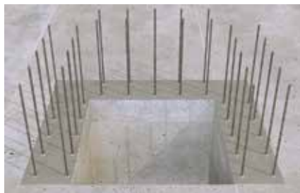
Dodatočne vlepené betonárske výstuže
