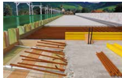
Vlepované betonárske výstuže
